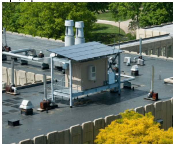
Рисунок 15 - Пример размещения микро-ЦОД на крыше здания
